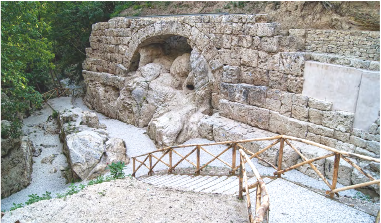
IL MANUFATTO DOPO IL RESTAURO DEL COMUNE DI TERNI, 2015
